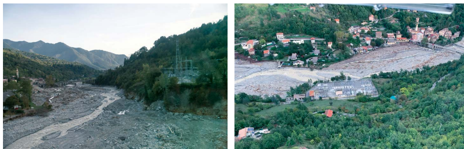
Figure 3 – Berge emportée aux abords d'un poste électrique lors de la tempête Alex.
