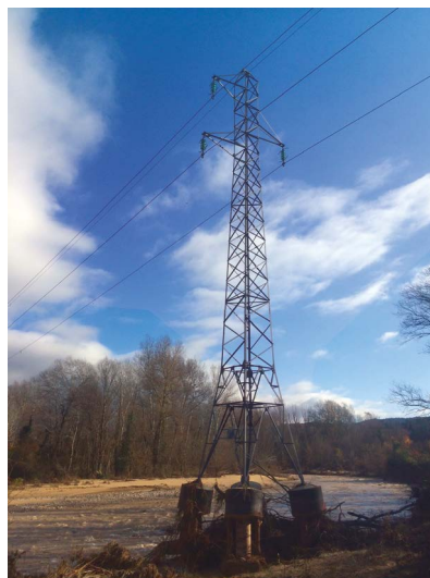
Figure 2 – Pylône liaison 63 kV Apt-Beaumette pendant et après une crue.
