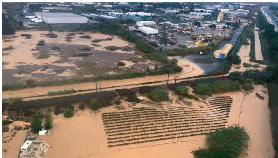
Figure 3 – Épisode méditerranéen du 22 et 23 octobre 2019. Inondation de la voie à Villeneuve-lès-Béziers.
